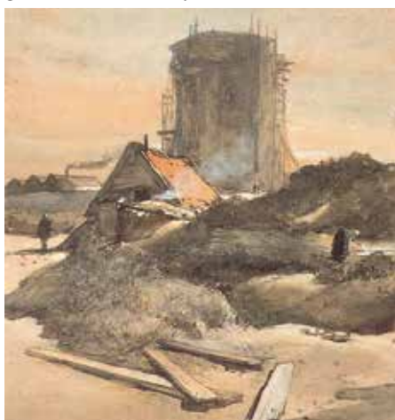
De Watertoren in aanbouw, ca. 1873. Aquarel van Johannes Bosboom
