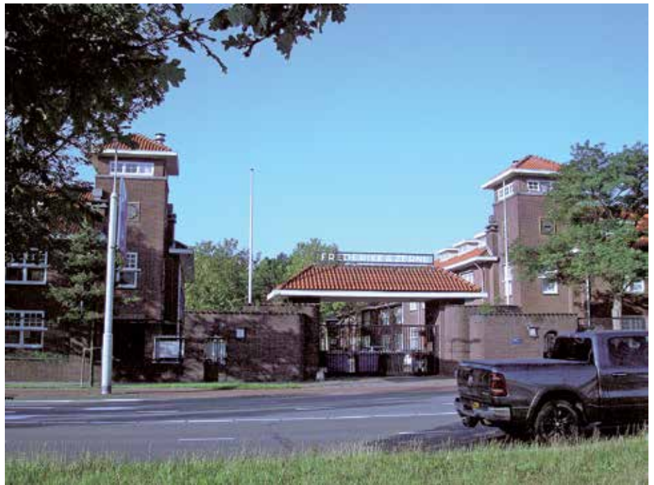
Oorspronkelijke toegang aan de van Alkemadeaan.
